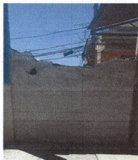
Foto 5: Reparacion de muro de construccion de 2.00 x 2.00 metros
