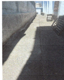
Foto 2: Reparacion de red de Drenaje y red de agua potable
